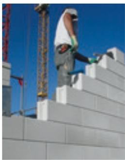
Une maçonnerie en PROFILA® ne nécessite pas de conditions préalables spéciales. Les règles applicables sont les mêmes que pour tout autre ouvrage de maçonnerie apparente. Nous recommandons la réalisation de plans d'appareillage montrant aussi les linteaux de fenêtres. Pour la maçonnerie extérieure, il convient de prévoir un socle de béton séparent le sol du premier rang de brique.
