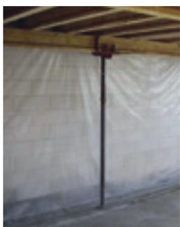
Il convient de protéger la maçonnerie contre l'absorption d'eau et les salissures. Avant le bétonnage de la dalle du plafond il importe aussi de revêtir les murs réalisés en briques PROFILA® d'une feuille protectrice.
