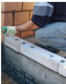
La première rangée de briques est posée avec du mortier normal, la liaison entre les rangées de briques suivantes s'opérant par un mortier-colle sur une épaisseur de 2-3 mm. Nous recommandons notre luge à mortier, à colle pour un travail efficace. Les joints d'about sont munis de rainures et crêtes qui, en général, ne nécessitent pas liant.
