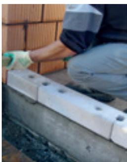
Die erste Steinlage wird mit Normalmörtel angesetzt. Die nachfolgenden Steinlagen werden mit Dünnbett [2-3 mm] verklebt. Wir empfehlen unseren Mörtelschlitten, um eine effiziente Verarbeitung zu gewährleisten. Die Stossfugen sind mit Nut und Kamm versehen und werden in der Regel nicht vermörtelt.
