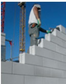
Ein PROFILA®-Mauerwerk braucht keine speziellen Voraussetzungen. Es gelten die gleichen Regeln wie bei anderen Sichtmauerwerken. Wir empfehlen, Schichtenpläne mit Sturz- und Fensterdetails zu erstellen. Beim Aussenmauerwerk sollte bis über das Erdreich ein Betonsockel errichtet werden.
