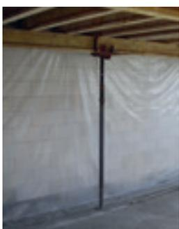
Es gilt, das Mauerwerk vor Durchnässung zu schützen. Auch vor dem Betonieren der Decke sollten PROFILA®-Wände wirksam abgedeckt werden.
