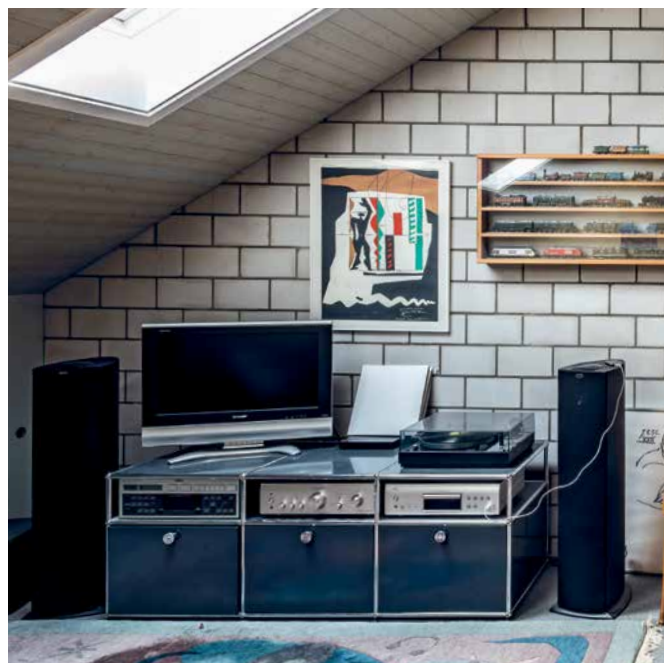
Mur apparent Épaisseur du mur 100–200 mm Indice d'affaiblissement acoustique R'w dB 46–52
